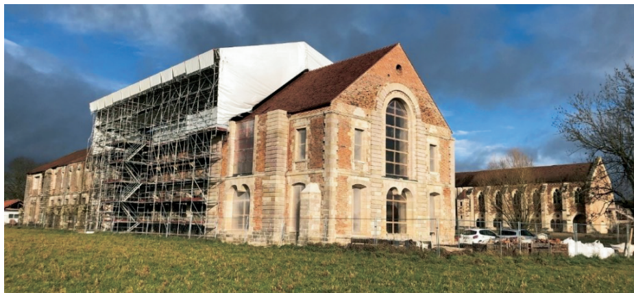
Le Définatoire de Cîteaux en cours de restauration (Photo : Guillaume Jean)
